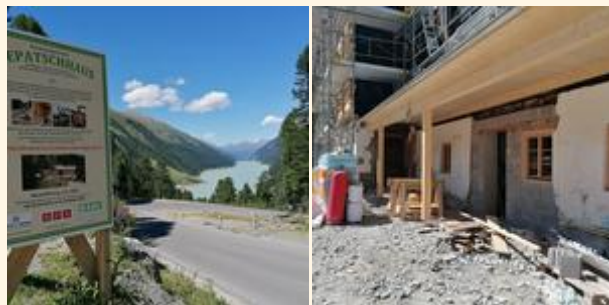
4. kilátás a buszmegállónál lévő kis elágazástól észak felé nézve, az építkezés tényét a tábla közli
